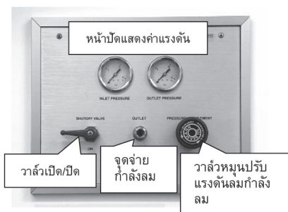
รูปที่ 1 ข้อต่อกำลังลมจากผนังไนโตรเจน
